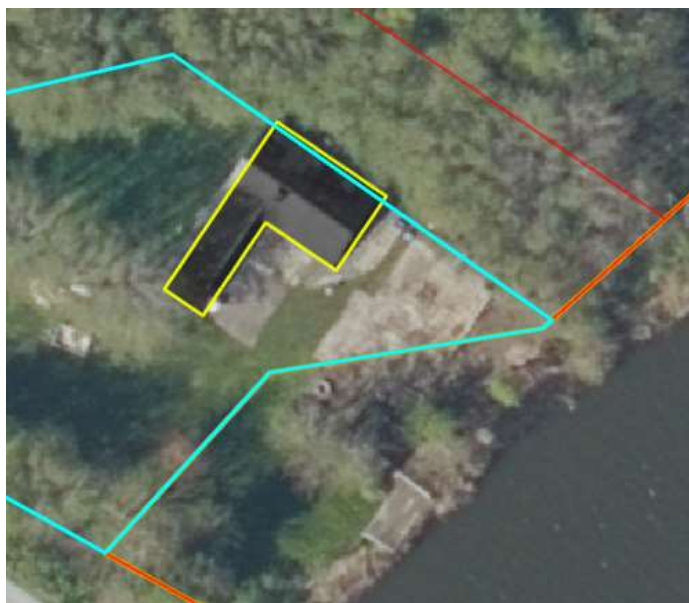
Luftfoto af en del af ejendommen, med placering af kolonihavehuset der nedrives markeret med gul
